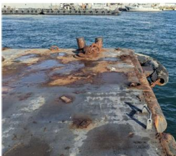
Extrémité de ligne AB, défenses et organes d'amarrage de ras
