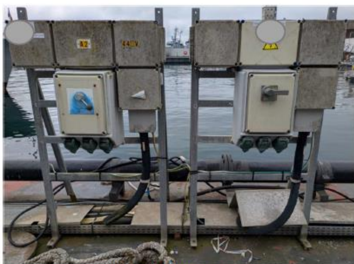
Un tableau électrique sur ponton
