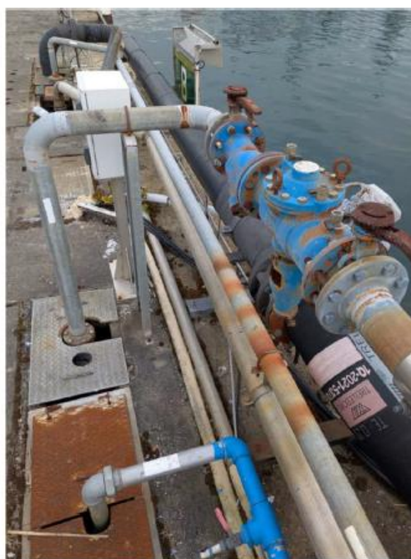
Vue des canalisations d'eau potable et d'air BP sortant de la galerie technique
