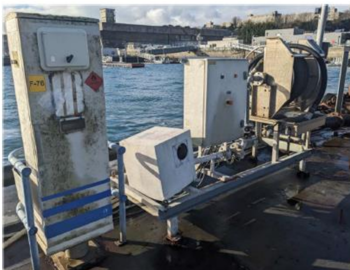
Distribution d'hydrocarbure avec enrouleur
