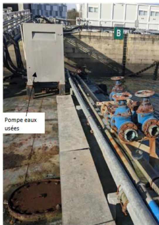
Pompe des eaux usées, chemin de câbles et fluides côté Bravo depuis le ponton
